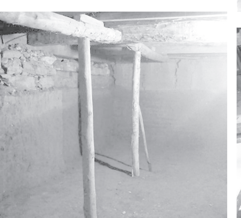
Detalhes do acabamento do porão da casa em taipa de pilão, pedras, tijolos e madeira
